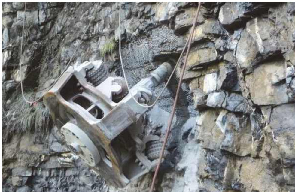
Fig. 5.4: Montage Raisebohrkopf
