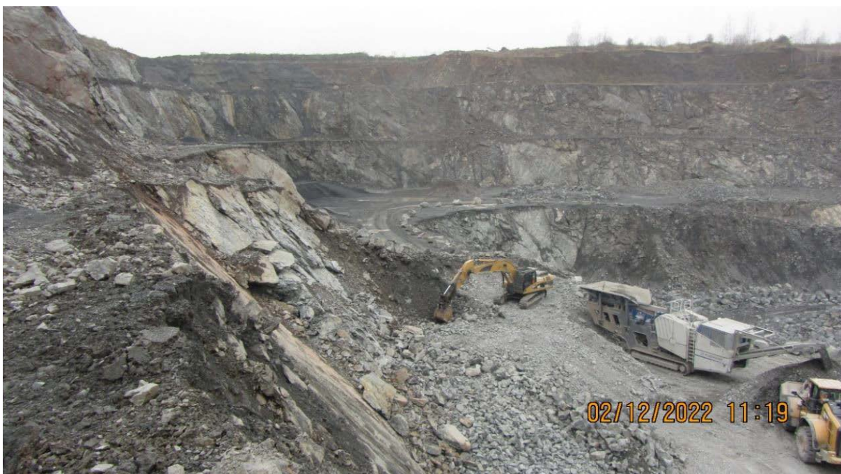
Abb. 2: Teilabbruch der Berme mit mobiler Aufbereitung.
