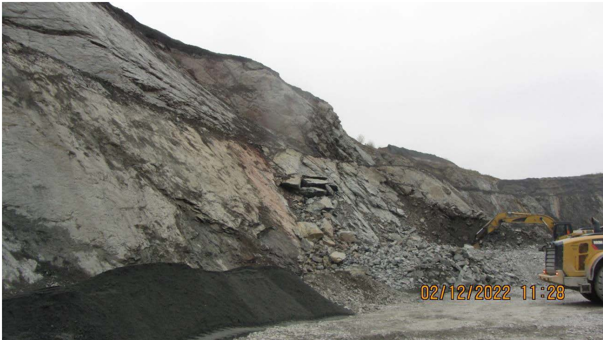
Abb. 3: bereits umgesetzte Teilverwallung des Böschungsfuß.
