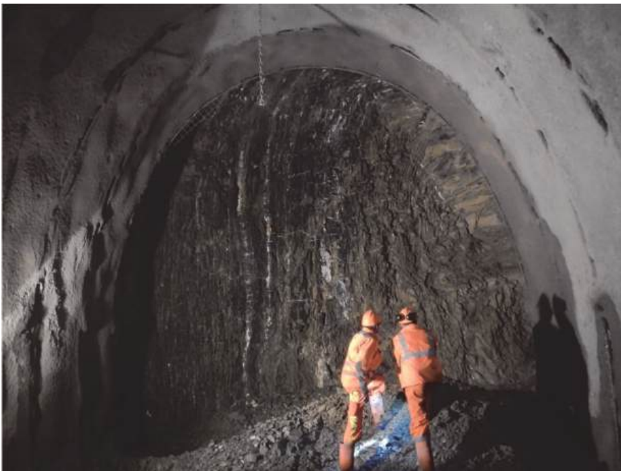
Fig. 9: Ortsbrust beim Vortrieb im Allgäuschiefer
