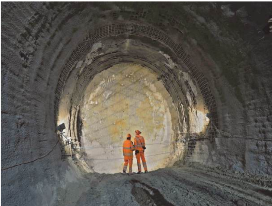
Fig. 13: Vortrieb in der Rauwacke durch den Gefrierkörper im Abschnitt III
