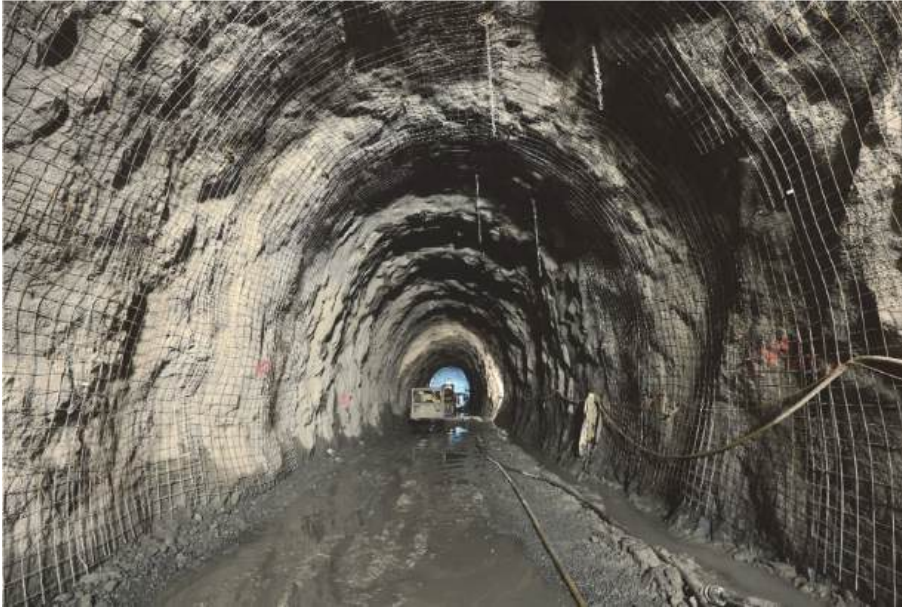
Fig. 16: Sprengvortrieb Spinas
