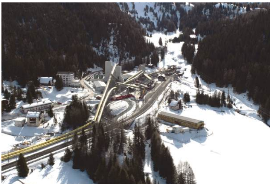
Fig. 6: Installationsplatz Preda mit Kieswerk, Förderbandanlagen, Personenunterkünften
