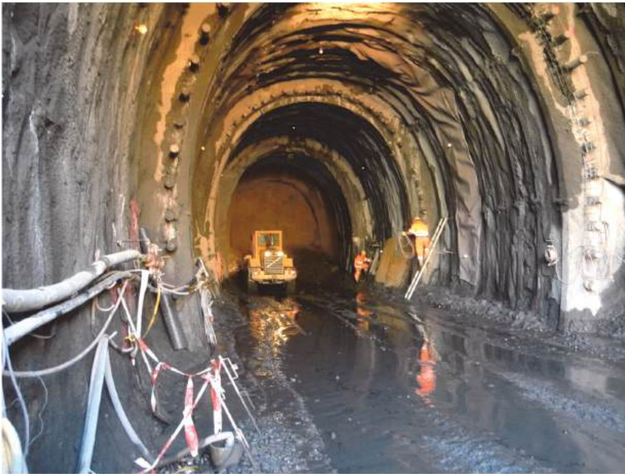
Fig. 8: Rohrschirmvortrieb Preda
