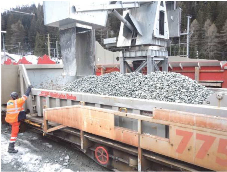
Fig. 18: Schotterverladung im Baubahnhof Preda
