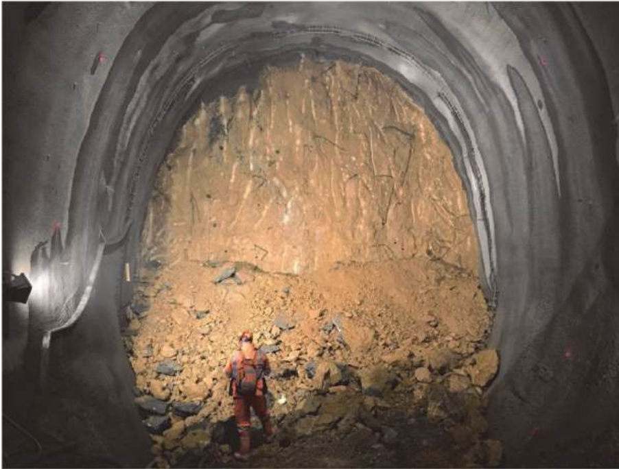
Fig 14: Ortsbrust beim Vortrieb in der Rauwacke - Abschnitt II
