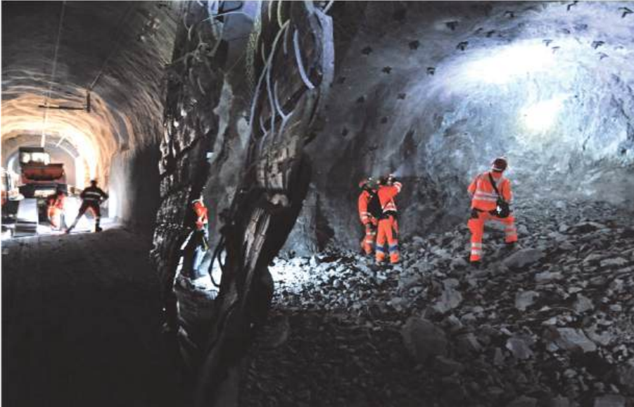
Fig. 3: Vorarbeiten im Albulatunnel I – zukünftige Querverbindung zum neuen Albulatunnel II
