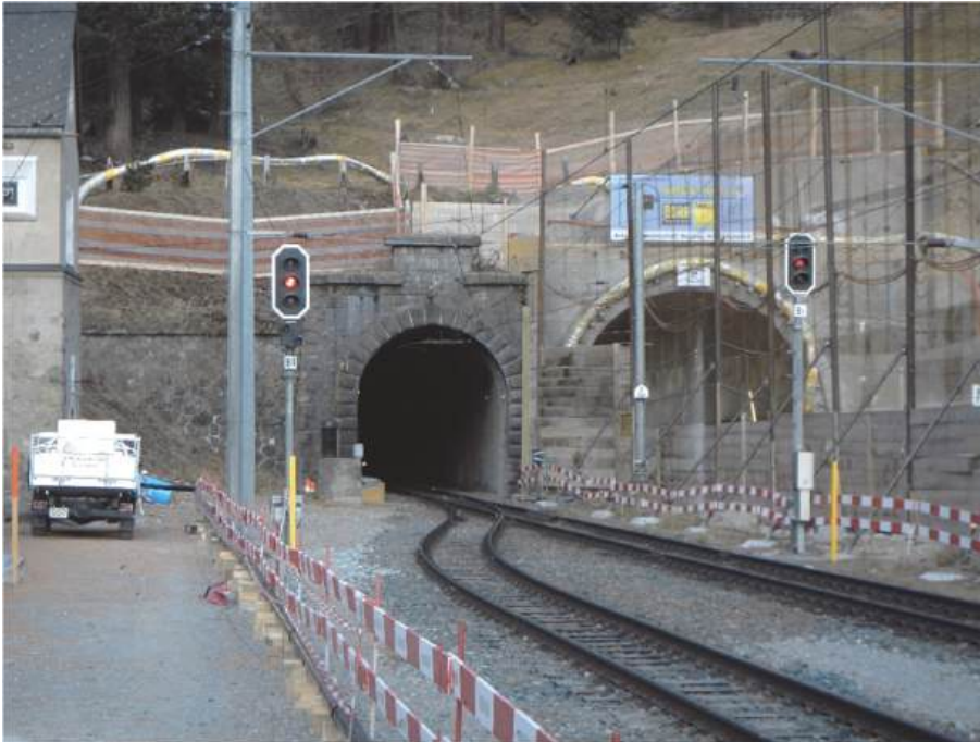
Fig. 15: Spinas – Situation Albatunnel I und Albatunnel II im Bauzustand
