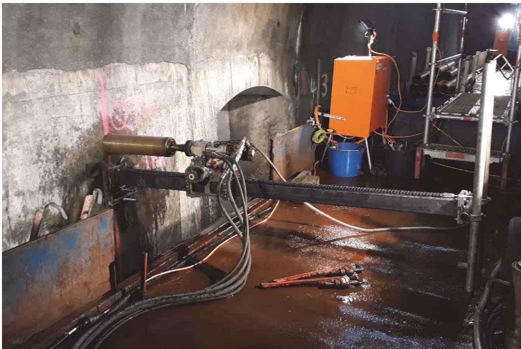
Fig. 3: Durchführung der horizontalen Bohrung QT4 RH mithilfe gleisgebundener Logistik
